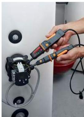
Misura della tensione su caldaia.
