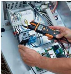
Misurazione della tensione di un compressore.
