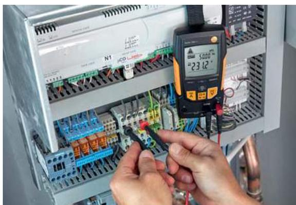
Controllo della tensione in scatole di commutazione di pompe di calore.
